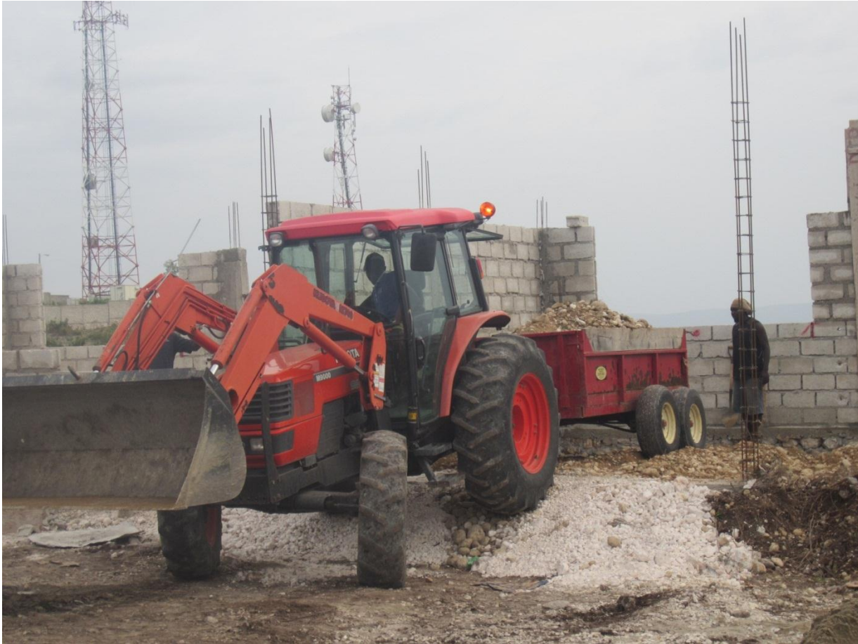
Juli 2012: die Grundmauern der neuen Schule stehen bereit
